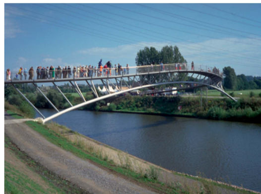
(d) Ripshorst bridge (Credit: SBP)
